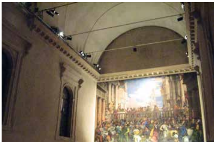
Sistema audio aereo, matrice a 8 canali (db technologies E6) e sistema dedicato ai dialoghi su piantana a 6 canali (Turbosound Impact 50).
